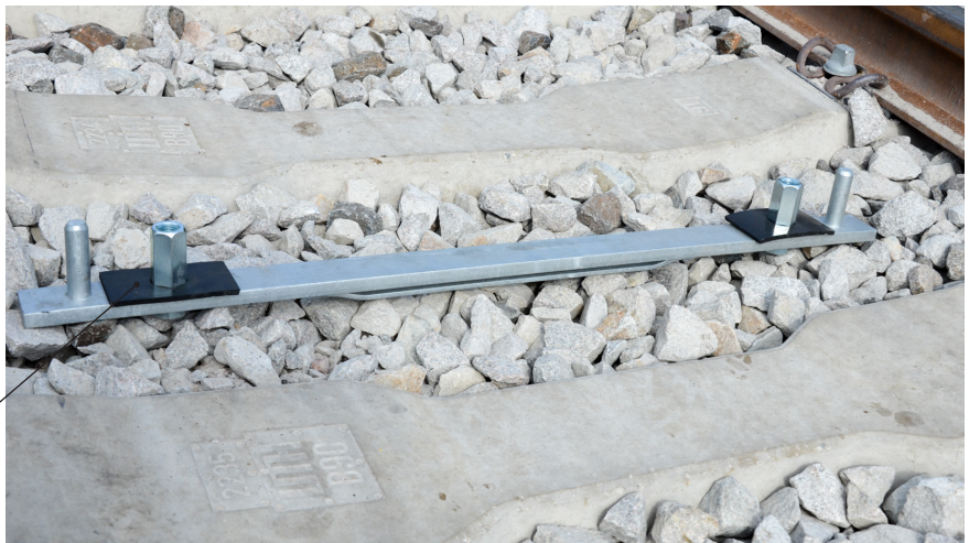
Bild 5 & 6: Ansetzen der Verspannsicherung Anfang mit Lasche für Auflaufkeil und Entkopplungsscheiben (Gummi, schwarz)
